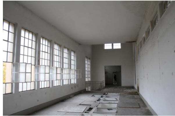
Innenbereich alte Trafostation
